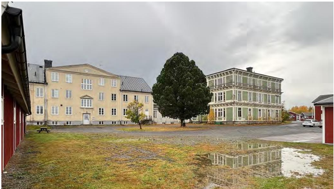
Figur 29. Den hårdgjorda ytan/parkeringen norr om vårdhemmet. Här finns en storvuxen silvertall placerad nästan som ett traditionellt vådräd. Bild, Kulturmiljöutredning Dp Sländan 45 m.fl.
