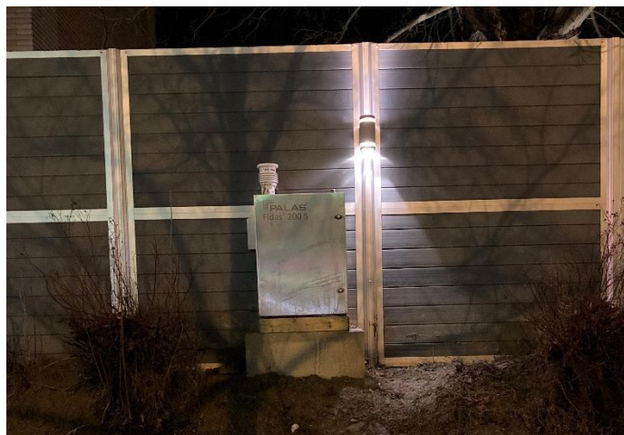
Figur 14 Centralesplanaden-Nygatan, Örnköldsviks kommun
