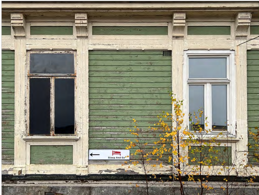
Ett av de bevarade ursprungliga utåtgående fönstren (vänster) jämte ett inåtgående så kallat insticksfönster (höger) på den norra flygeln. Indelningen är densamma men de nätta dimensionerna saknas i det högra fönstret.
