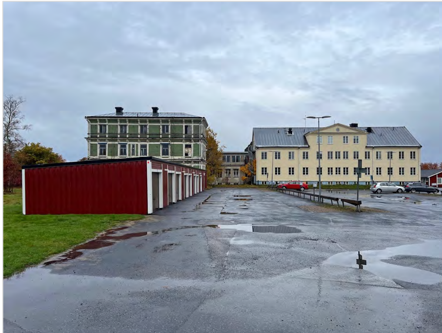
Den asfalterade parkeringen söder om vårdhemmet.
