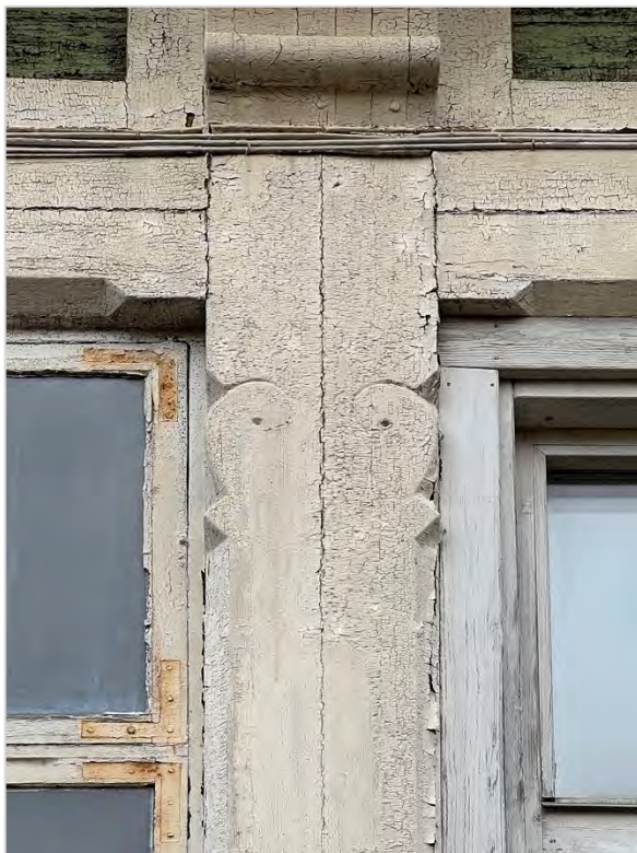
Ett av de bevarade ursprungliga utåtgående fönstren (vänster) jämte ett inåtgående så kallat insticksfönster (höger) på den norra flygeln. Indelningen är densamma men de nätta dimensionerna saknas i det högra fönstret.
