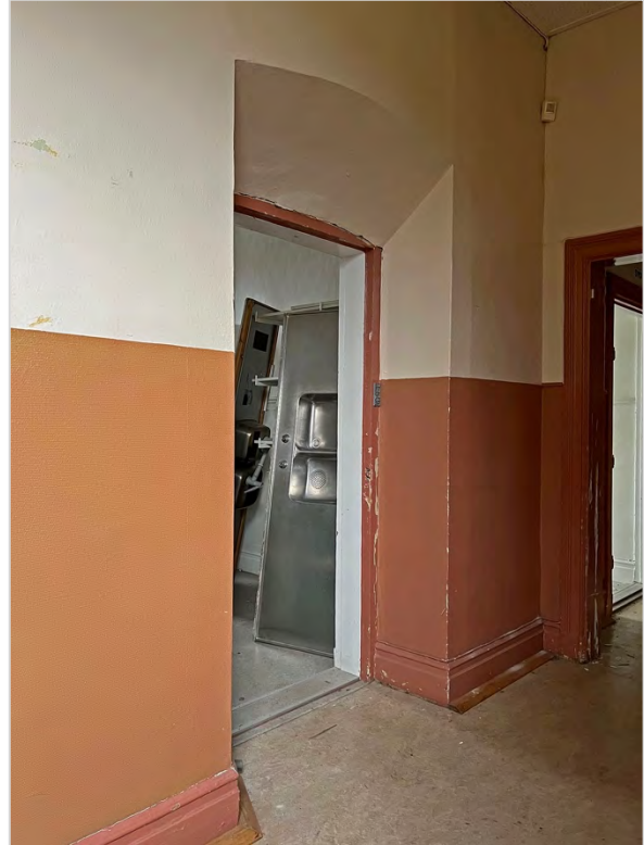
Vänster: En av flyglarnas korridorer på andra våningen. Här finns bröstpanelen, pärlsponten i taket, dörrarna och listverket från år 1891 kvar.
