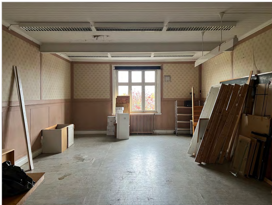
Ett av logementen på andra våningen. Här finns bröstpanelen, fältindelningen av väggarna, pärlsponten i taket och listverket fortfarande kvar sedan år 1891. Kakelugnen försvann tillsammans med de övriga i huset när centralvärme installerades på 1910-talet.
