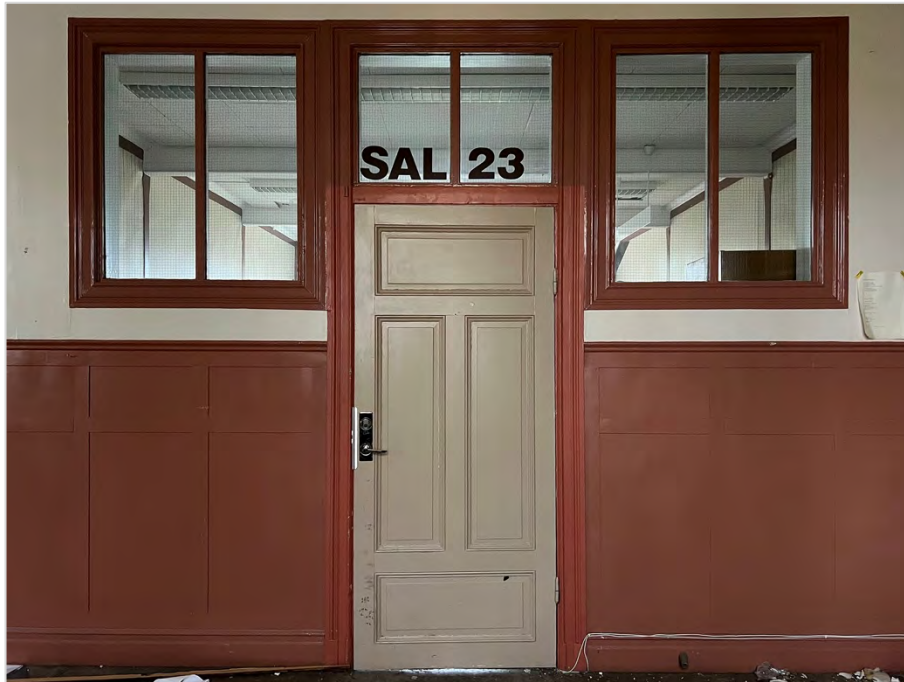
En av de bevarade dörrarna till logementen på andra våningen. Fönsterpartierna gav indirekt ljus från fönstren i korridoren utanför. Fönstren, dörren, bröstpanelen och listverket är bevarade sedan byggnaden uppfördes år 1891.
