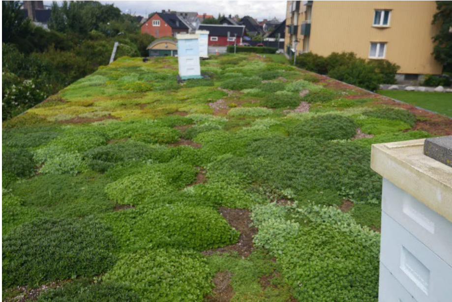
Figur 4. Exempel på utformning av sedumtak. Sedumtak på garage i stadsdelen Seved, Malmö. Boverket: www.boverket.se/sv/PBL-kunskapsbanken/teman/ekosystemtjanster/praktiken/grona/grona-tak/
