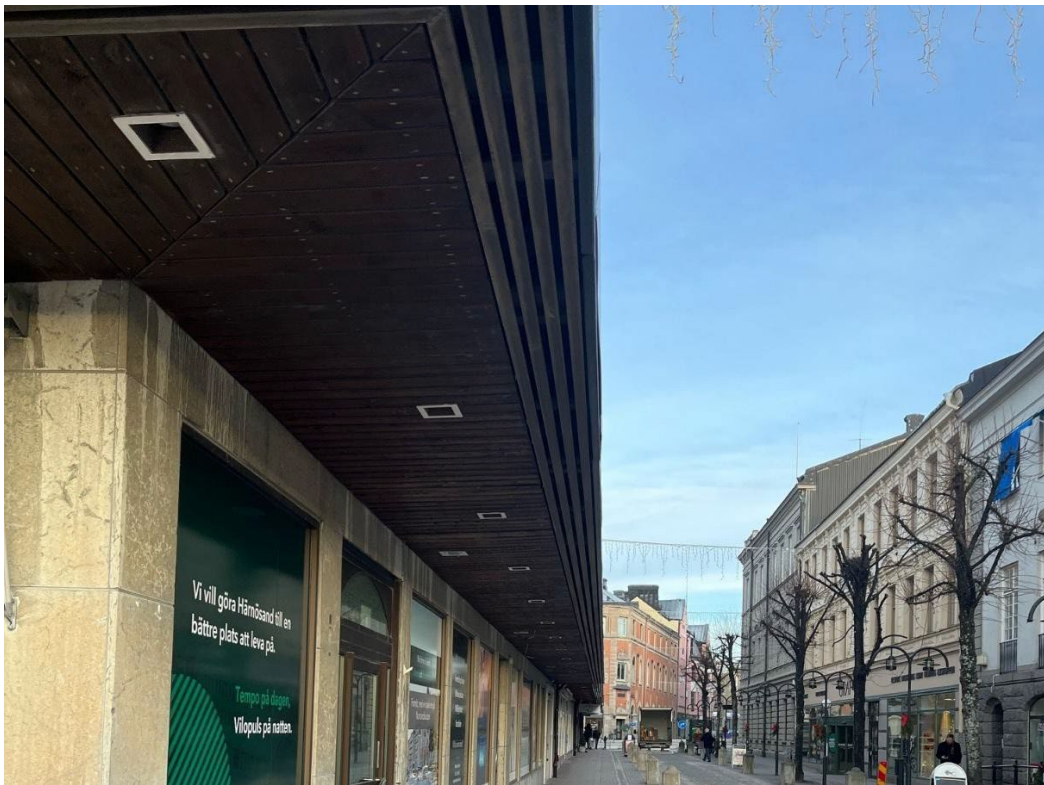
Figur 11. Skärmtaket längst Köpmangatan.
