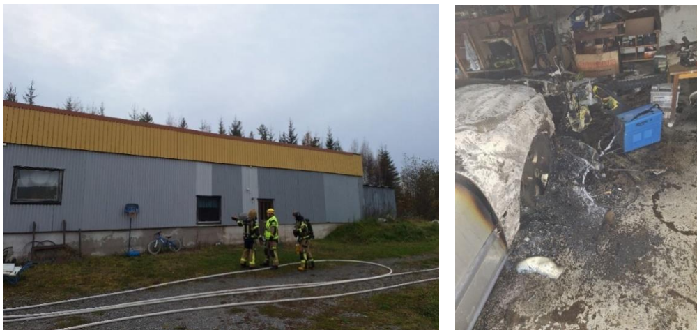
Bild 2-3: Garagebyggnaden där branden inträffade samt startutrymme
