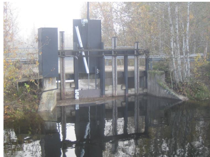
Dammen fotograferad från uppströmssidan
