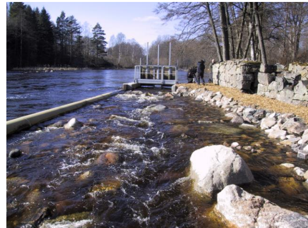
Inlöp vid Hemsjö nedre, Mörrumsån
