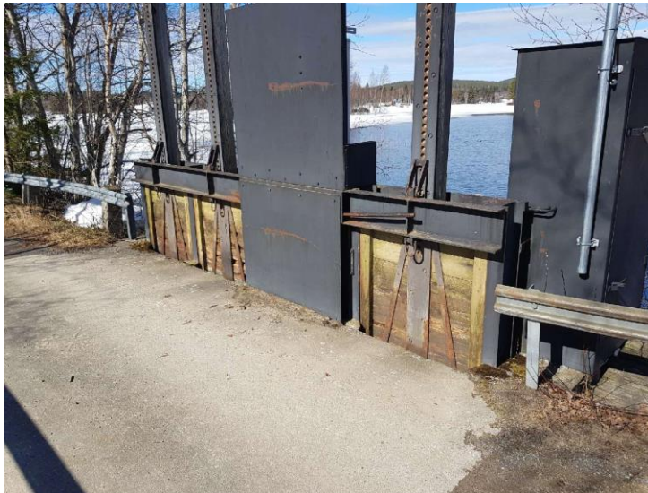
Dammen regleras med 4 lika breda spettluckor
