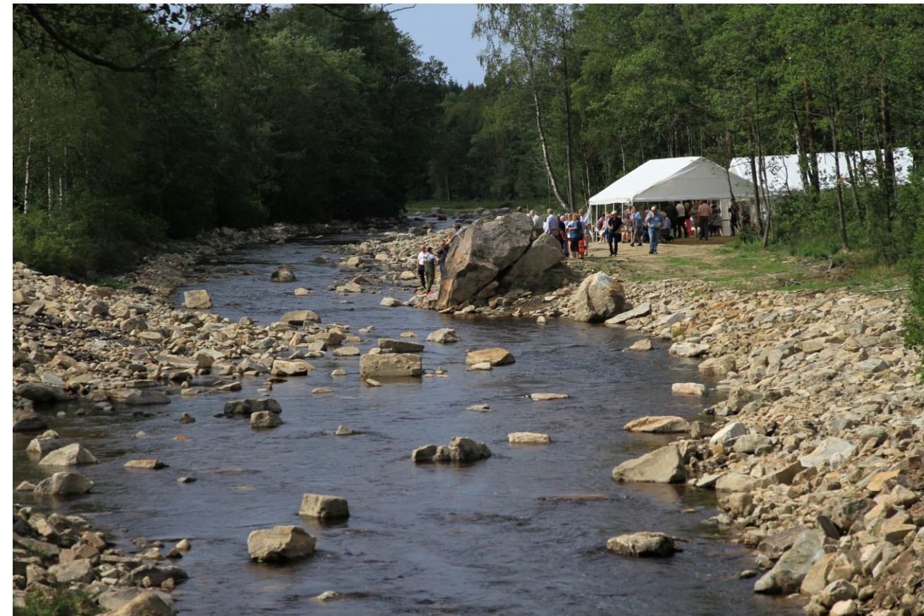
Figur 2. Exempel på oregelbundet placerade block i den återskapade åfåran i Örne å mellan Unnen och Bolmen.
