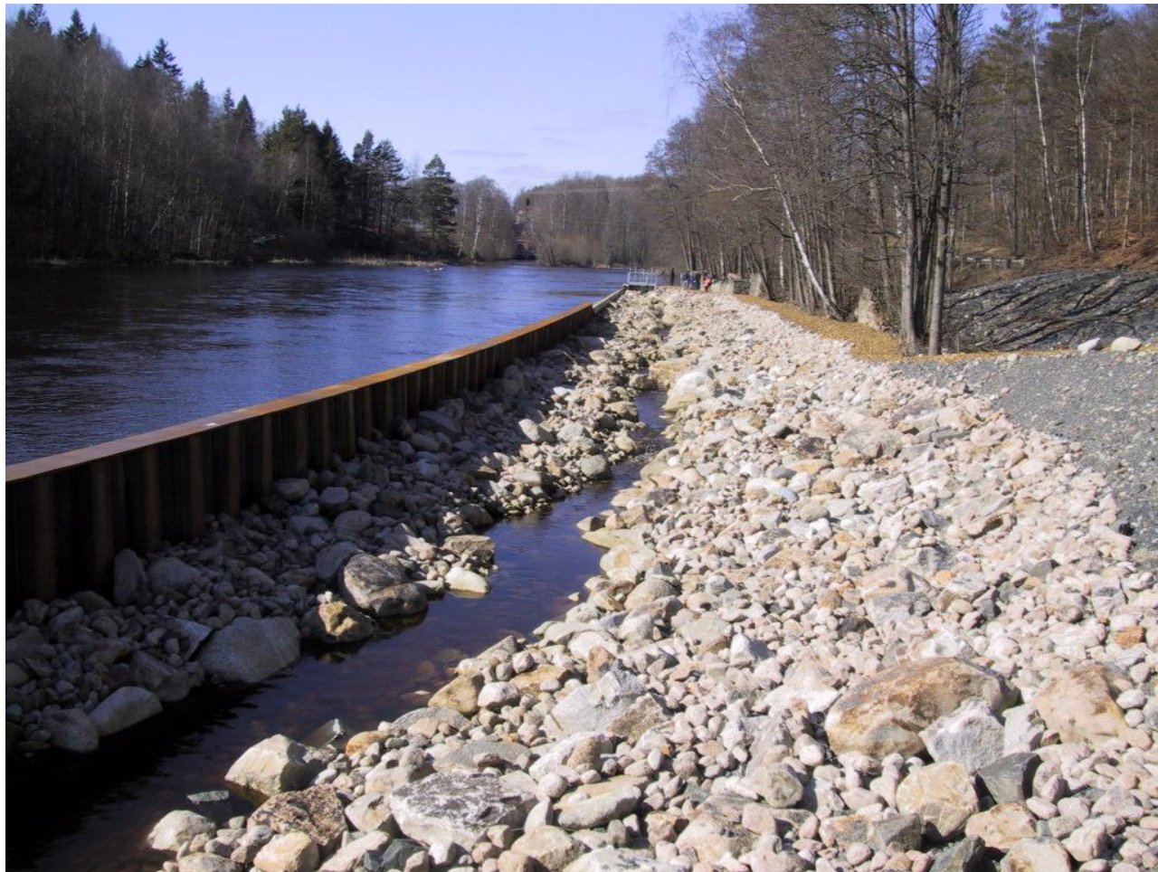
Figur 1. Exempel på lågvattenränna i inlöp vid Hemsjö nedre, Mörrumsån. Inlöpet är ej i drift när fotografiet är taget. Lutning 2 %.
