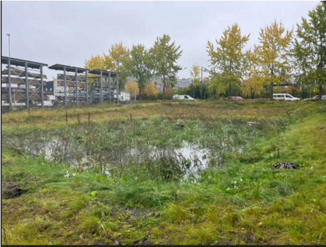
Figur 13. Exempelbild på nedsänkt biofilter vid nederbördstillfälle i Östersund (WSP, 2024).
