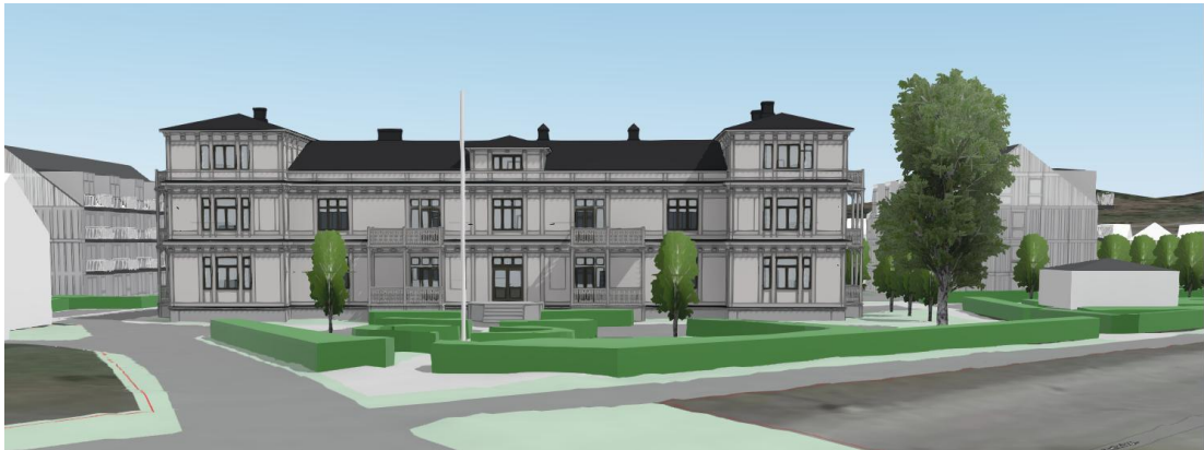
Figur 21. Vy från Volontärvägen mot Hus A med nyrenoverad fasad och grön friyta framför huset. I bakgrunden skymtas de nya bostadshusen Hus C och D. Fullt utbyggd plan.
