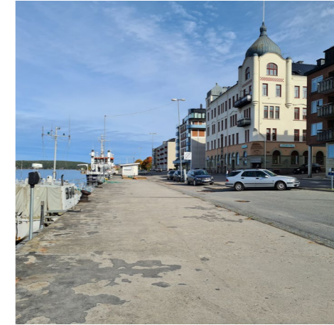
Stora hårdgjorda ytor längs Skeppsbron
