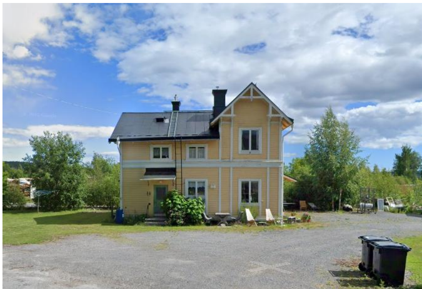
Figur 26. Fotografi på Stationshuset.
