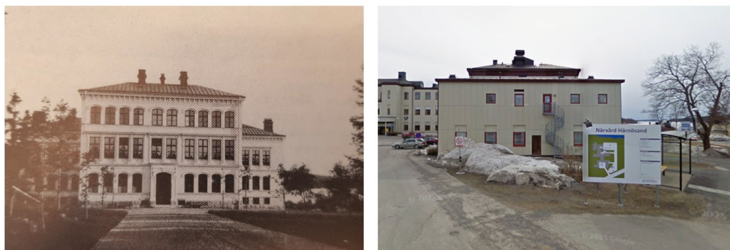
Figur 31. Institutionsbyggnadens ursprungliga arkitektur och framsida i vänster bild (Västernorrlands museum). Institutionsbyggnadens framsida idag i höger bild.
