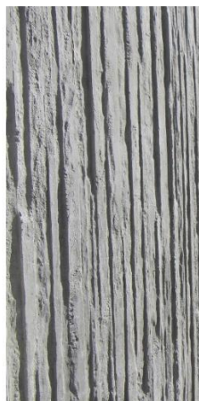
Betongsockel och betongmurar med formgjutet mönster
