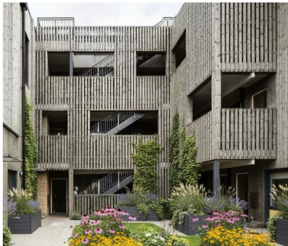
Träribbor Naturbehandlade träribbor på fasaden (lite ljusare nyans än träpanelen) fortsätter som räcke på balkongen
