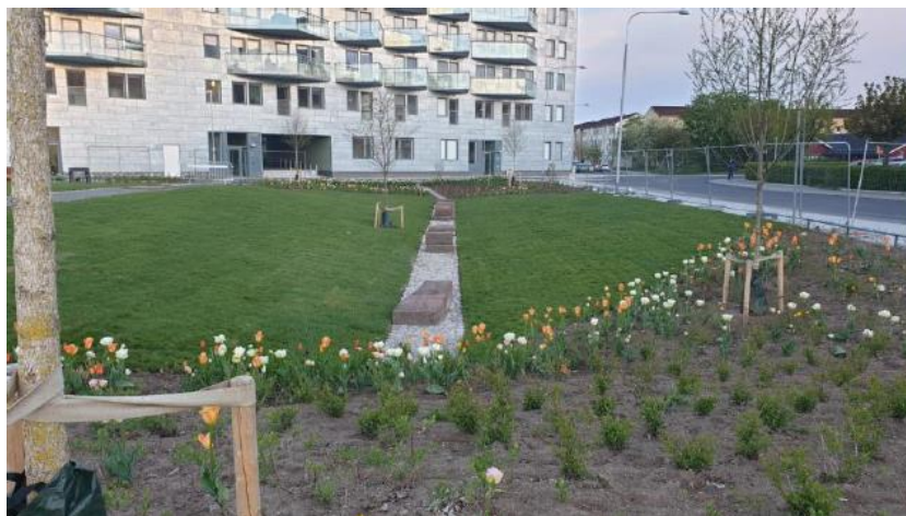
Figur 22. Exempel på nedsänk grönyta/torrdamm. Bild: Sweco.
