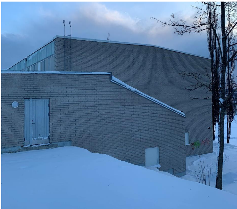
Figur 30. Franzénhallen har byggts i suterräng
