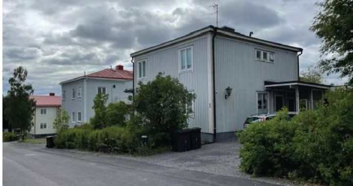
Figur 34. Hus längs med Ängevägen (Kvarteret Klubban).
