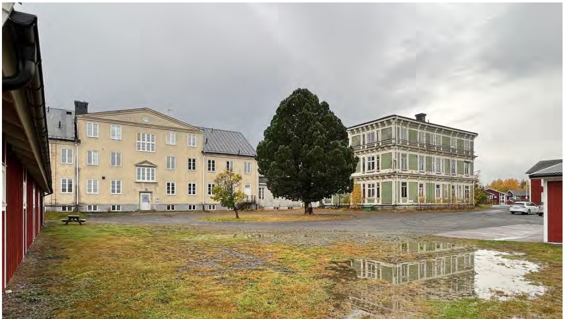
Figur 31. Den hårdgjorda ytan/parkeringen norr om vårdhemmet. Här finns en storvuxen silvertall placerad nästan som ett traditionellt vådräd. Bild, Kulturmiljöutredning Dp Sländan 45 m.fl.
