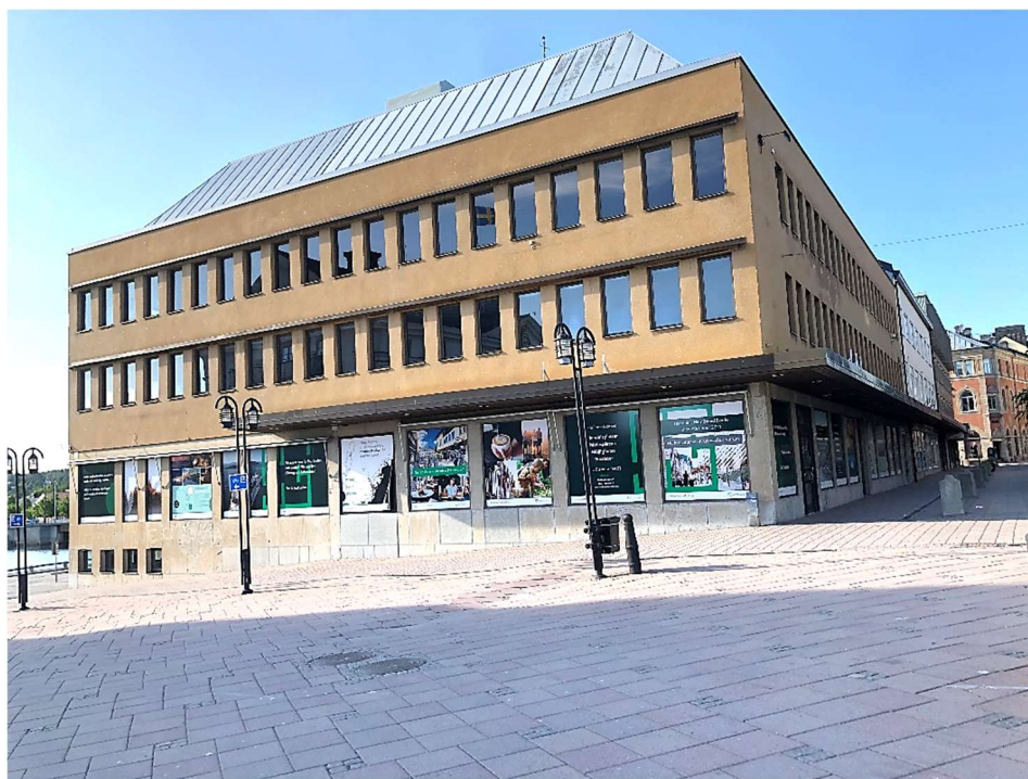
2023 06 24. Köpmannen 10, fasad mot söder / torget.
