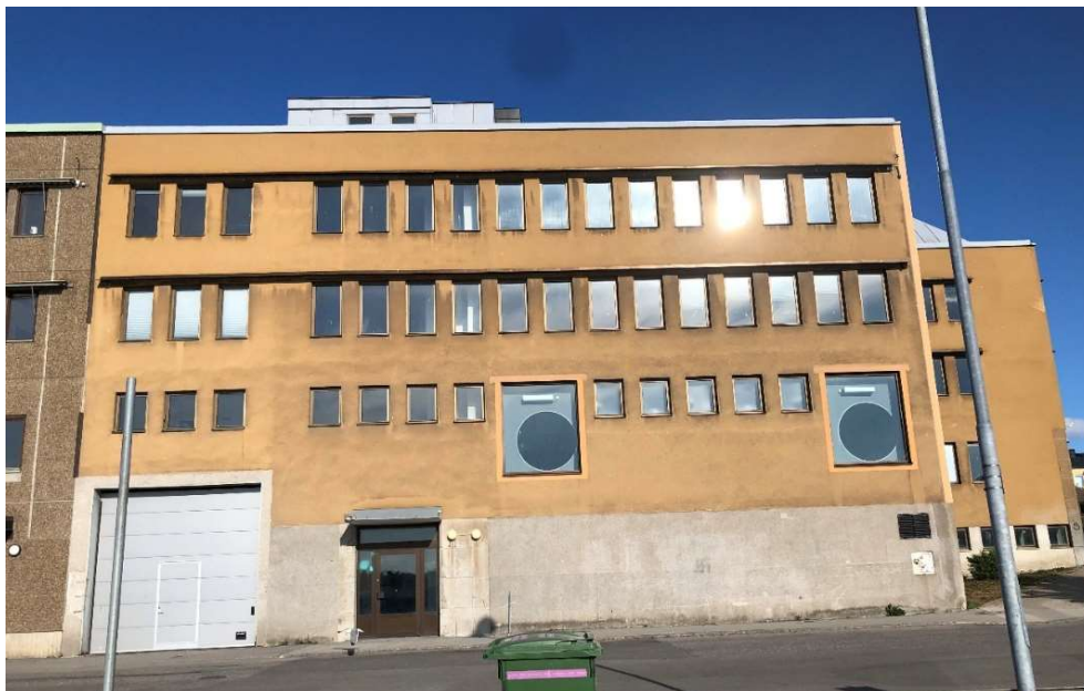
2023 06 24. Köpmannen 10, fasad mot väster / Skeppsbron.
