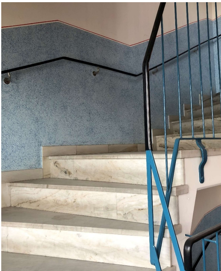
2023 07 12. Marmorbeläggningar i trappor och trapphus.
