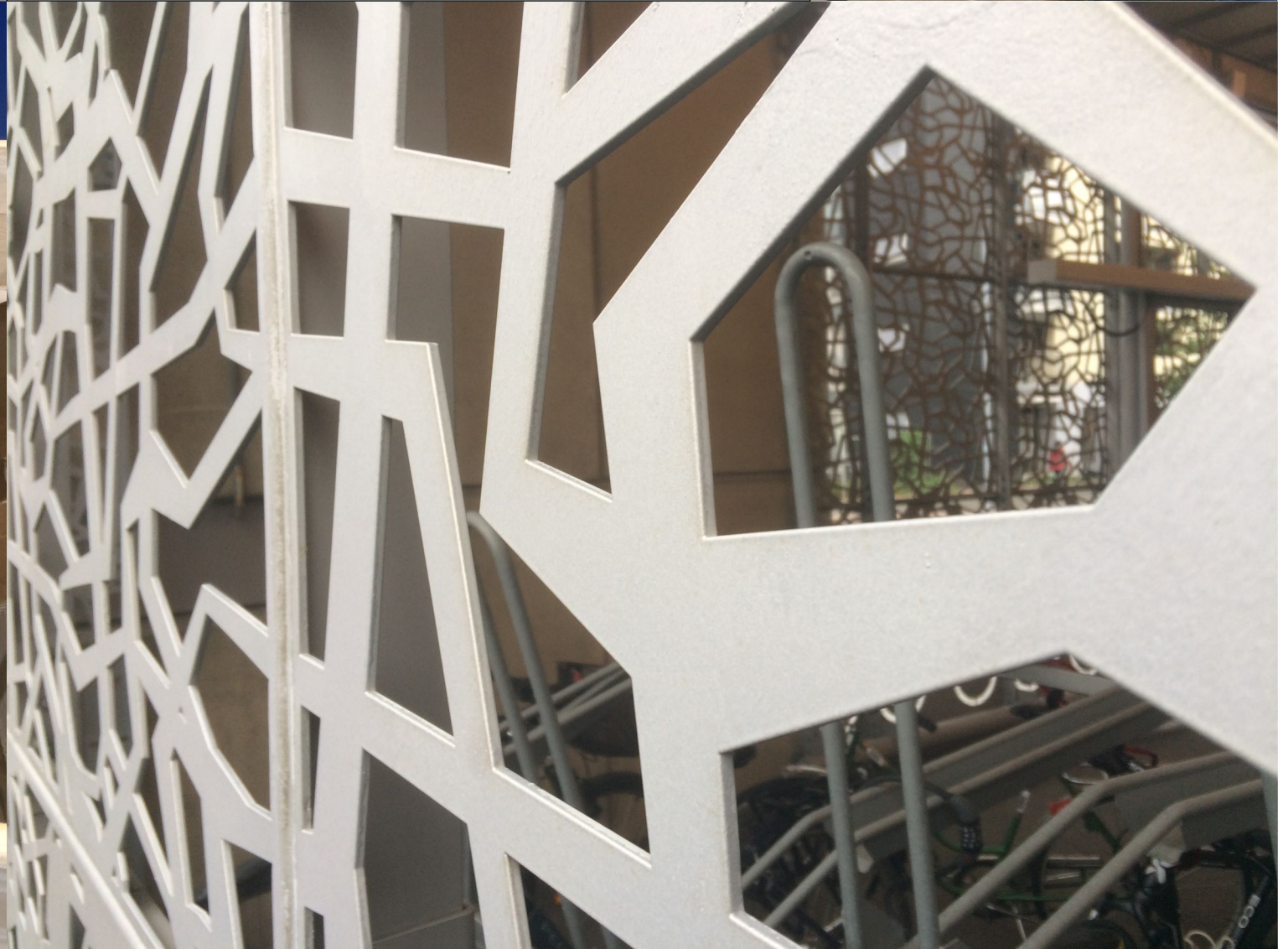
Bilder tatt ved bedriftsbesøk /research ved IMS som kan produsere platene. Bildene viser hvordan platene kan knekkes for å danne en bue
