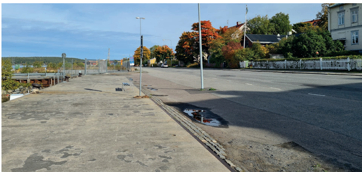
Figur 42: Breda bilgator som uppmanar till hög hastighet och eftersatt skötsel på kajen för gående och cyklister
