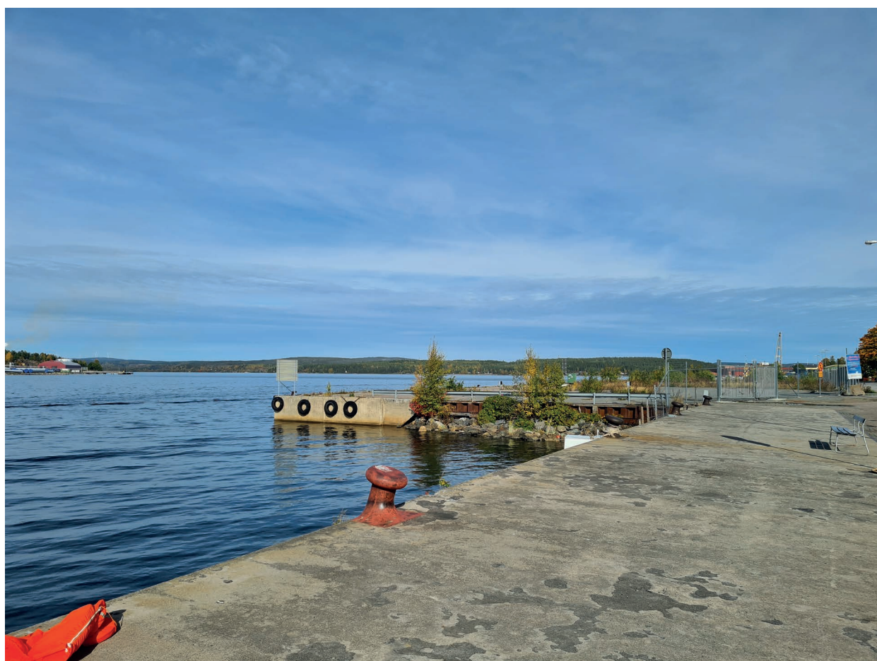
Figur 41: Bild på Utsprångskajen som tidigare varit en livfull plats som nu är avstängd på grund av rasrisk
