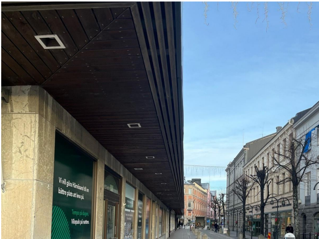
Figur 11. Skärmtaket längst Köpmangatan.
