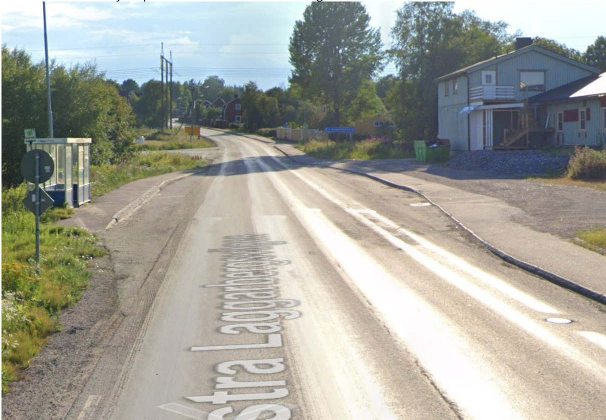
Laggarberg, Timrå - 4,5 påstigande per dygn 2019 (hållplatsklass D) Ficka samt väderskydd på ena sidan - bra utformning
