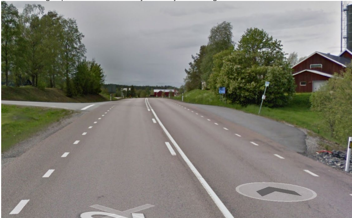
Skog v332, Kramfors - 16 påstigande per dygn 2019 (hållplatsklass C) Ficka men ingen plattform eller väderskydd - okej utformning
