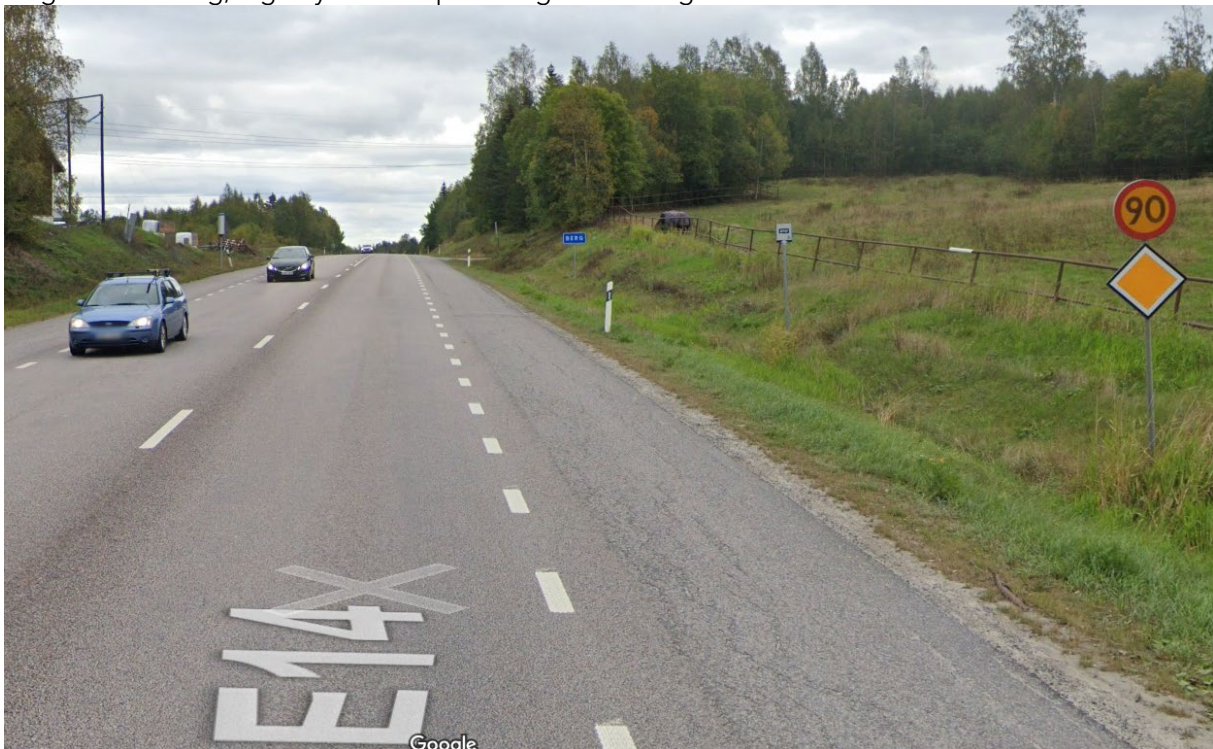
Berg E14, Sundsvall - 0,9 påstigande per dygn 2019 (hållplatsklass E) Högtrafikerad väg, ingen yta att stå på - dålig utformning
