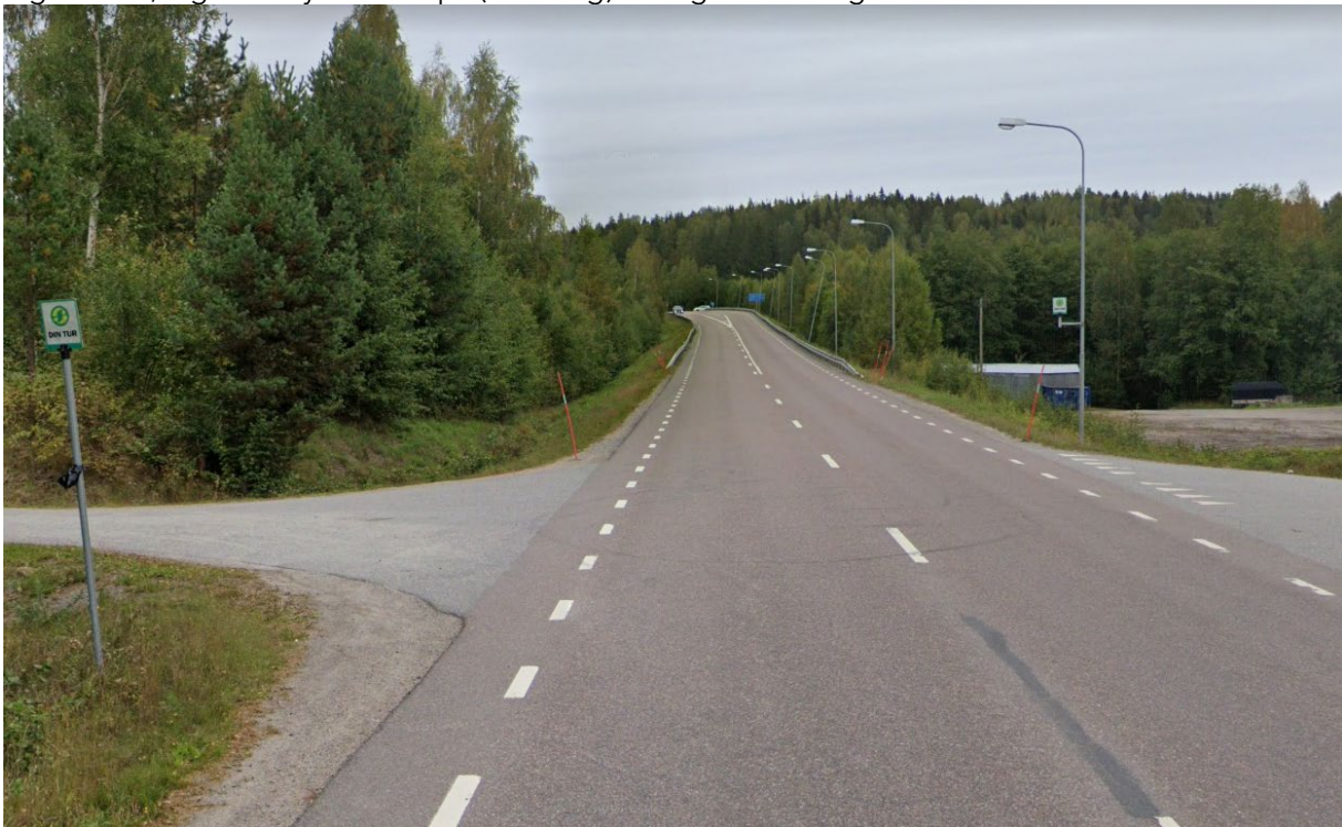
Matforsbron norra, Sundsvall - 2,7 påstigande per dygn 2019 (hållplatsklass D) Ingen ficka, ingen bra yta att stå på (korsning) - dålig utformning
