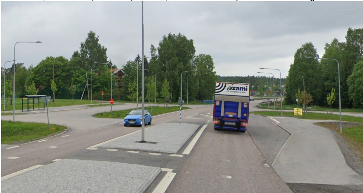
Älandsbro skola, Härnösand - 17 påstigande per dygn 2019 (hållplatsklass C) Ficka med plattform respektive separat hållplats med väderskydd - bra utformning.
