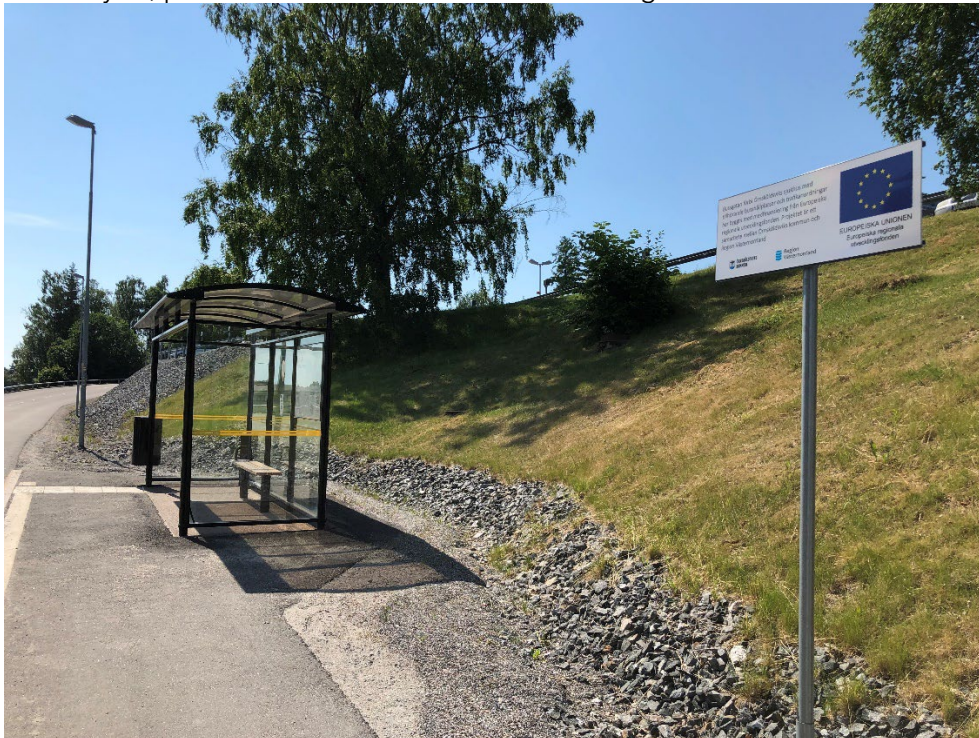
Industrigränd Örnsköldsvik - 56 påstigande per dygn 2019 (hållplatsklass B) Ingen 17cm plattform, inget taktilstråk - dålig utformning
