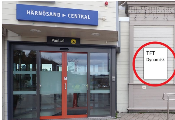
Bild 1: Placering av Trafikverkets kommande skylt på stationshuset
