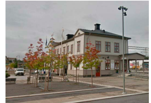
Stationshuset i dämpad varmgrå färgskala
