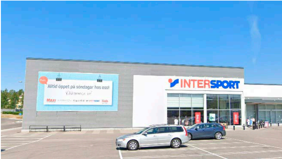
Mörkare slutna väggdelar, ljusare partier mot entré sida. Skärmtak och uppglastat kring butiksentréer
