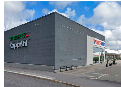
De slutna väggdelarna får liv genom skyltning
